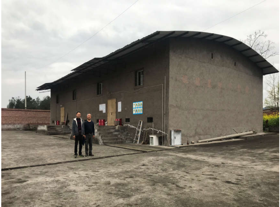
(附项目勘察相关图片)
